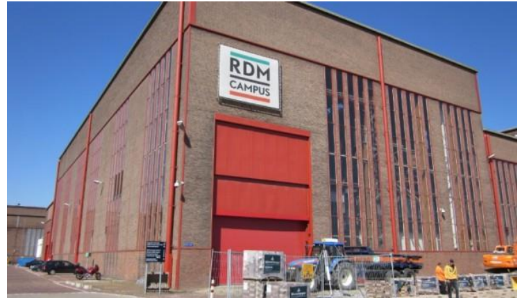
Rotterdam : RDM Campus
