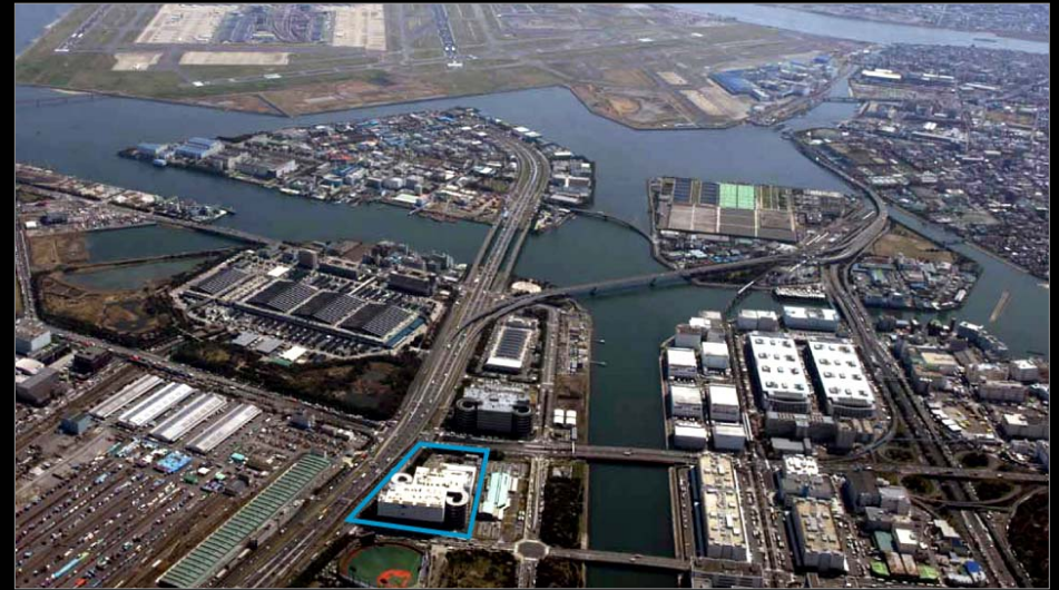
Tokyo, AMB Ohta Distribution Center, 790 ksf
