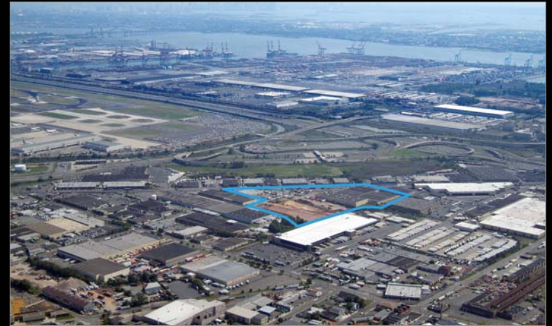
AMB Portview Commerce Center, NNJ
