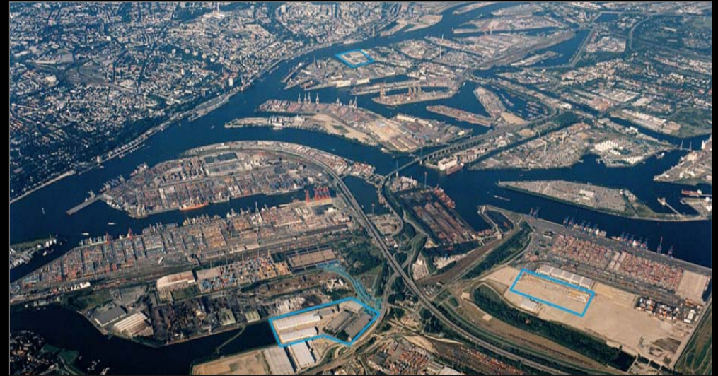
Port of Hamburg, 12 AMB facilities totaling 1.8 msf
