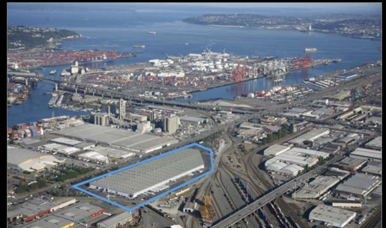
AMB Portside Distribution Center, Seattle/Tacoma
