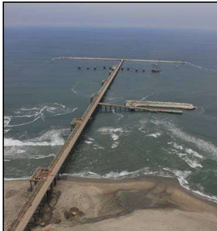
Terminal Portuario de Melchorita
