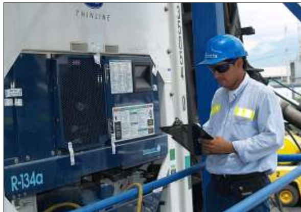
MONITOREO Y SUMINISTRO DE ENERGIA
