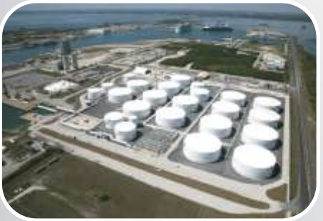
Servicios de Distribución de Combustible para Buques
