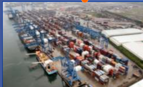
Manzanillo International Terminal (MIT)
