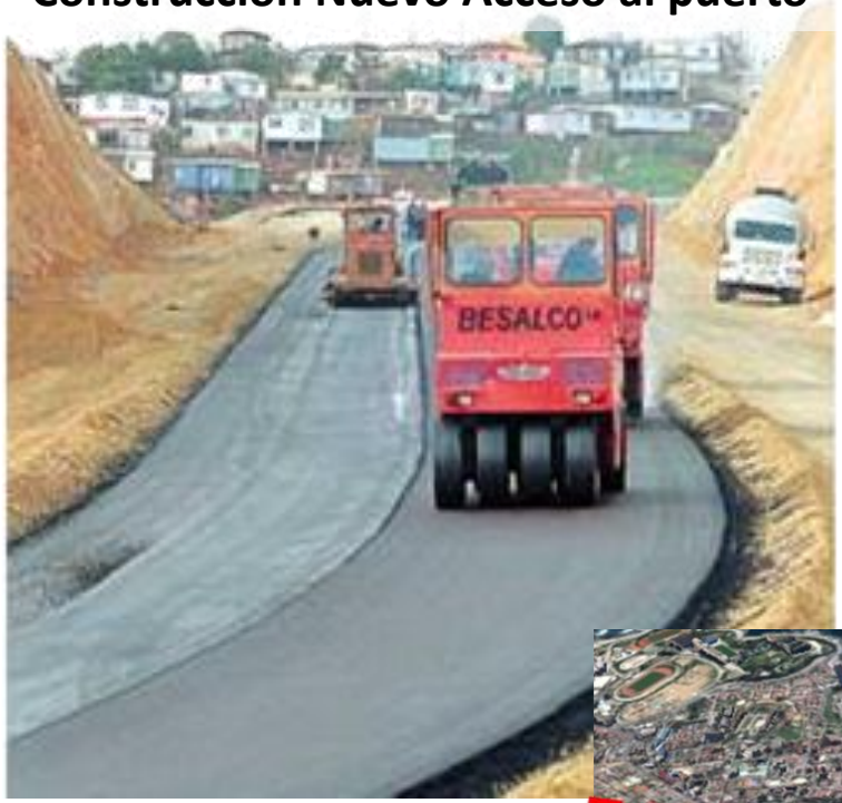
Construcción Nuevo Acceso al puerto
